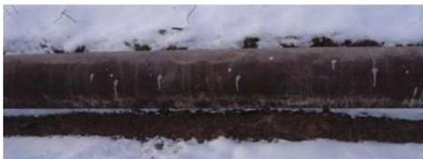
**Вывод: Суммарная мощность тепловых потоков достаточна, чтобы на холодной, "окажушке" интенсивно таял снег и висели сосульки.**
